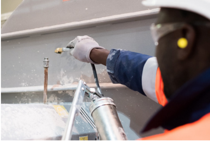
Fig. 2. Le geste de raccordement de l'agent de lubrification. Crédits photographiques : Gilfor SA.
